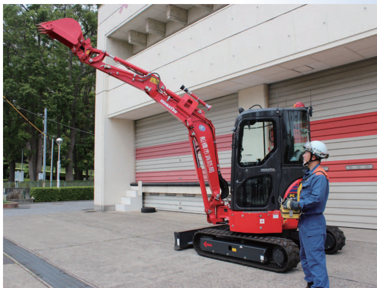
写真2 ラジコンによる遠隔操作
